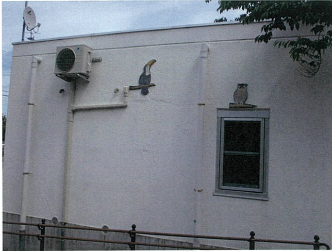
駐車場入口側
